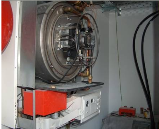
Plinski kondenzacijski kotel pri montaži
