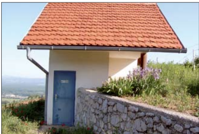
Vodohran Avguštine nad Kostanjevico
