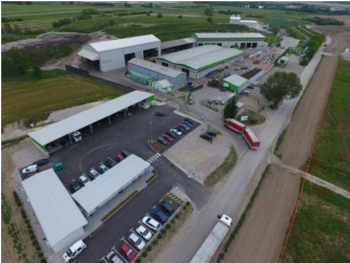
Slika 2: Center za ravnanje z odpadki Spodnji Stari Grad
