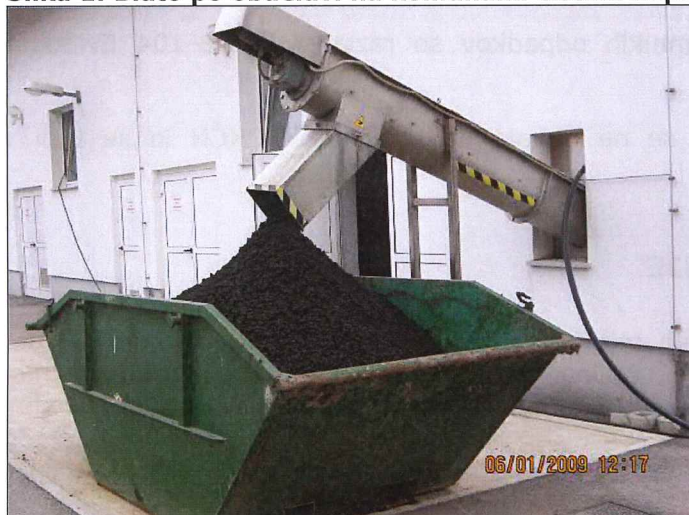
Slika 1: Blato po obdelavi na komunalni čistilni napravi Brestanica
