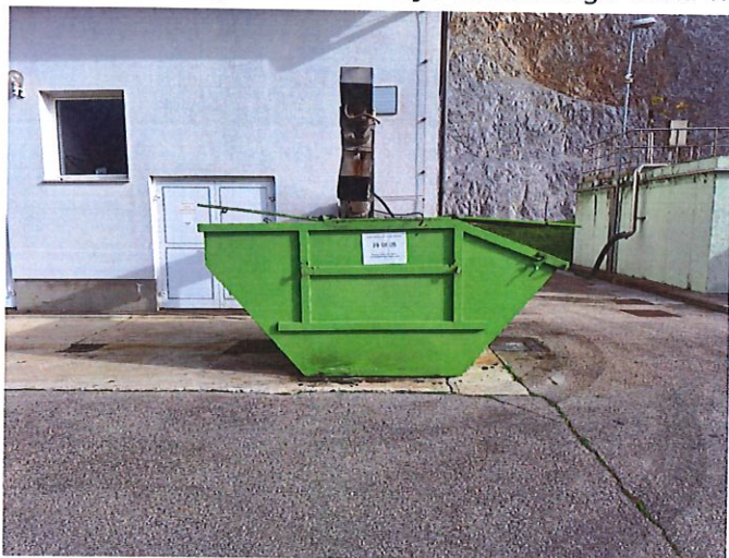
Slika 1: Kontejner za zbiranje obdelanega blata na komunalni čistilni napravi Brestanica
