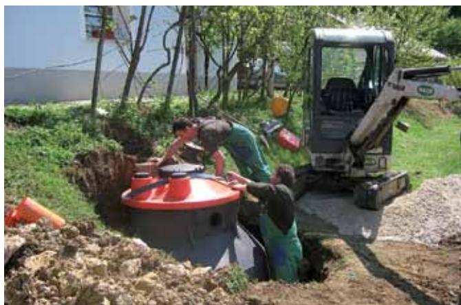
Vgrajevanje male biološke čistilne naprave
