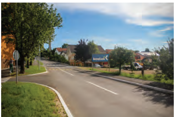
Prenova Cankarjeve ulice v Krškem
