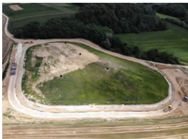
Izvedba del na lokaciji odlagališča Tremajne, Sveti Ivan - Žabno
