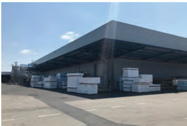
Hala Adria Mobil, Novo mesto
