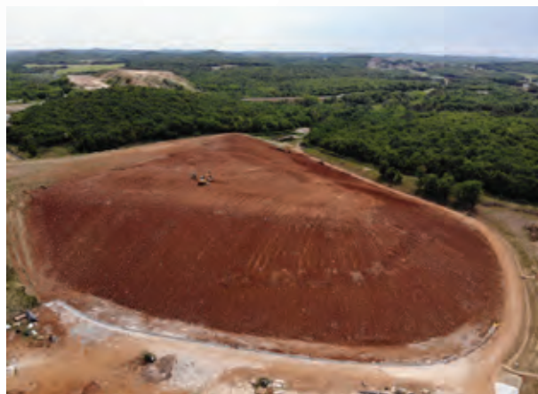
Prekrivanje z geosintetiki na odlagališču Košambra pri Poreču
