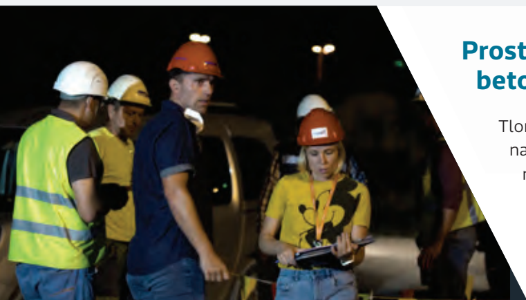
Gradbena dela potekajo tudi ponoči, med vikendi in prazniki
