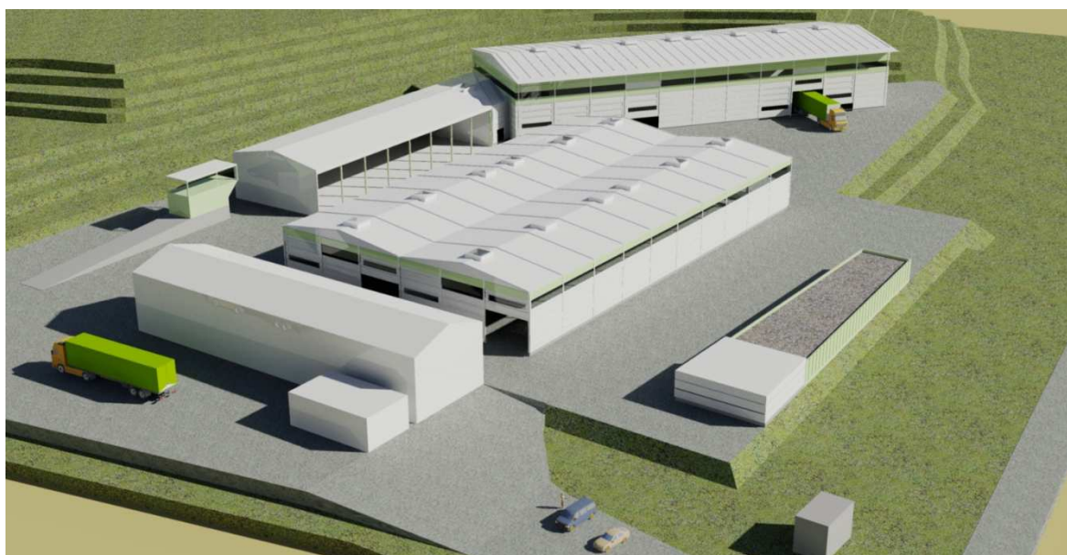
Slika 1: Center za ravnanje z odpadki Spodnji Stari Grad
